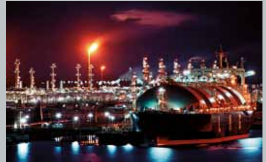
Air Fin Coolers in LNG applications
